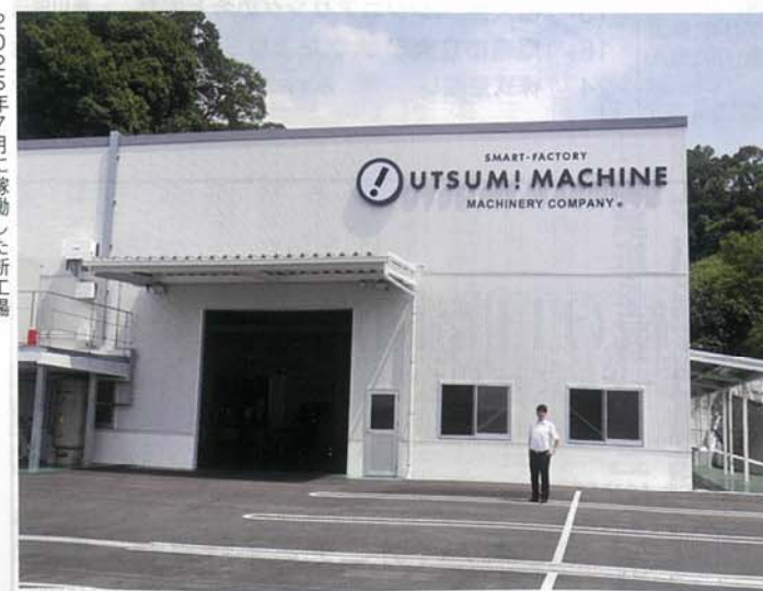
2025年7月に稼働した新工場
